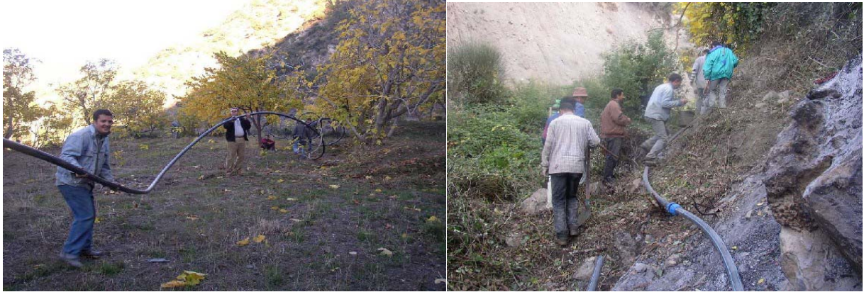
Le chantier d'installation de la conduite d'eau à Tazla
